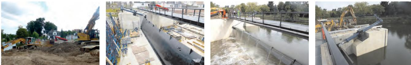
Als Anforderungen an jeden einzelnen RACO-Elektrozylinder® ergaben sich eine Stellkraft von 80 Tonnen und ein Hub von 4500 mm. Da die Elektrozylinder mittels kardanischer Aufhängung an den Fundamenten angebracht worden sind, erforderte dies unsererseits eine exakte Berechnung der Biegebeanspruchung. Mithilfe der „Finite Elemente Methode“ haben unsere Ingenieure die CAD Daten überprüft und die Sicherheitsfaktoren der im Kraftfluss liegenden Komponenten bestätigt.
