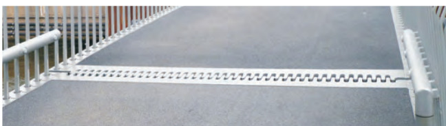
Das Kammprofil zwischen den Segmenten im Bereich der Fußgänger und Radfahrer!
